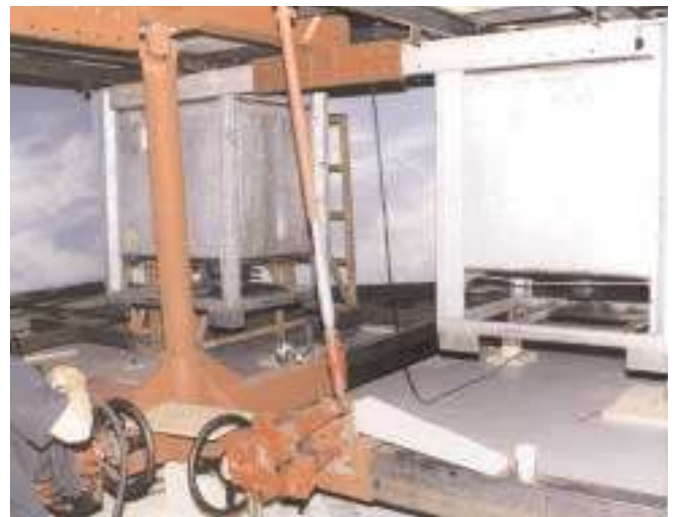
Zwei Wassertanks sorgten für ausreichende Balance
